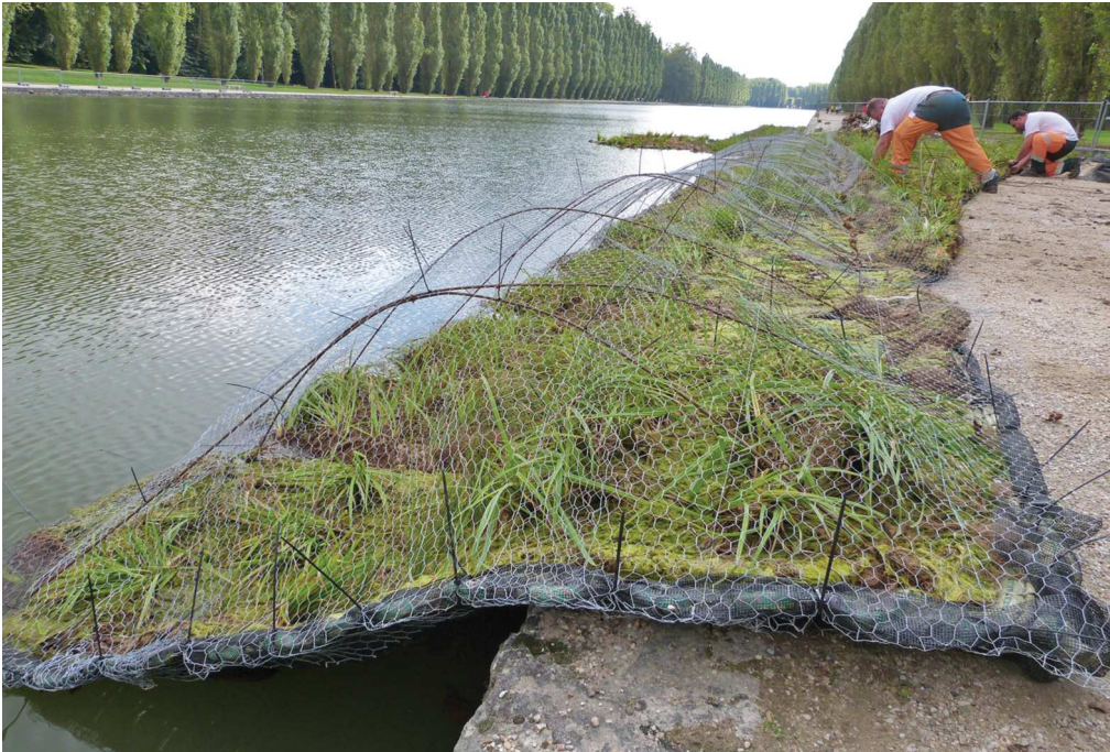
Expérimentation de mise en place de radeaux flottants végétalisés, sur le grand Canal. © CD92/O. Bouviala
