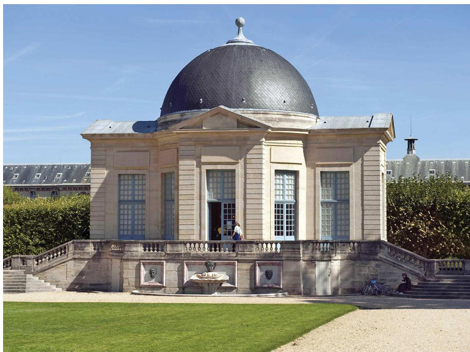
Façade ouest du pavillon de l'Aurore © CD92/J.-L. Dolmaire
